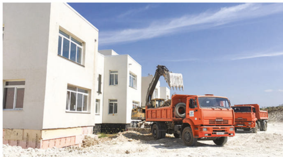
Вокруг детсада рабочие копают котлован для прокладки дренажа. Фото автора
