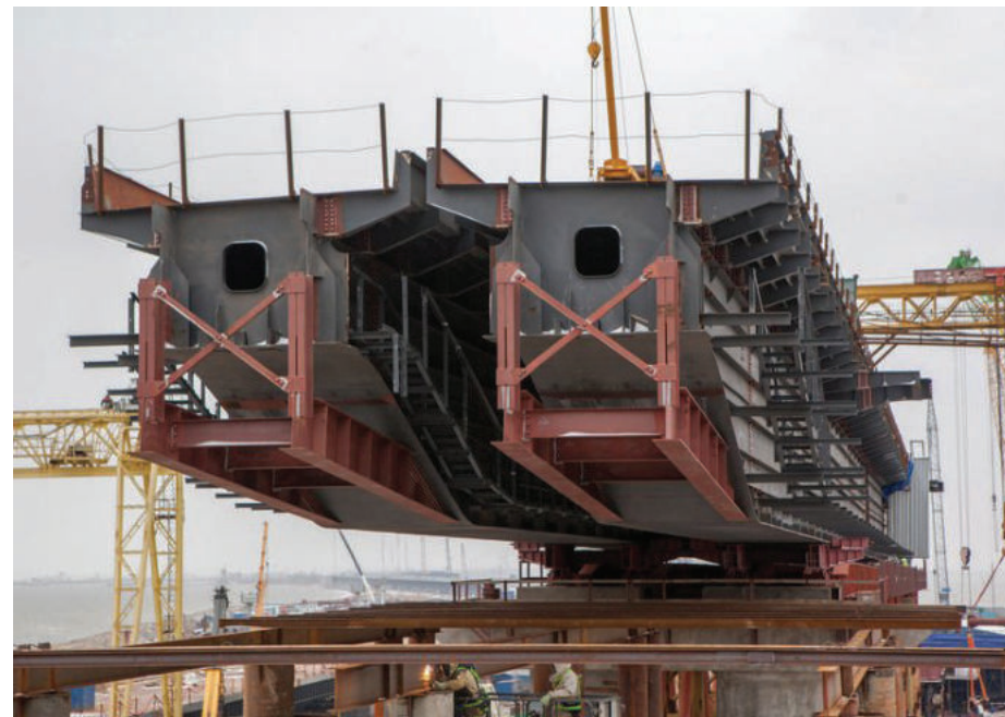
Железнодорожный пролёт моста – это сборная металлическая конструкция весом 580 тонн, включающая более 40 основных элементов. Они соединяются между собой сваркой и высокопрочными болтами Фото: most.life
