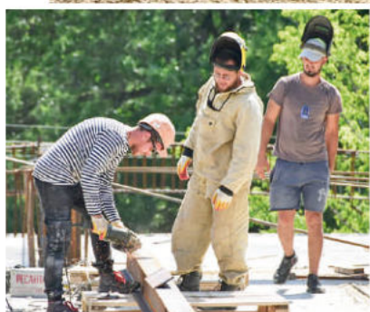
Строительные работы по возведению художественного училища достигли середины. Фото: Михаил ГЛАДЧУК
