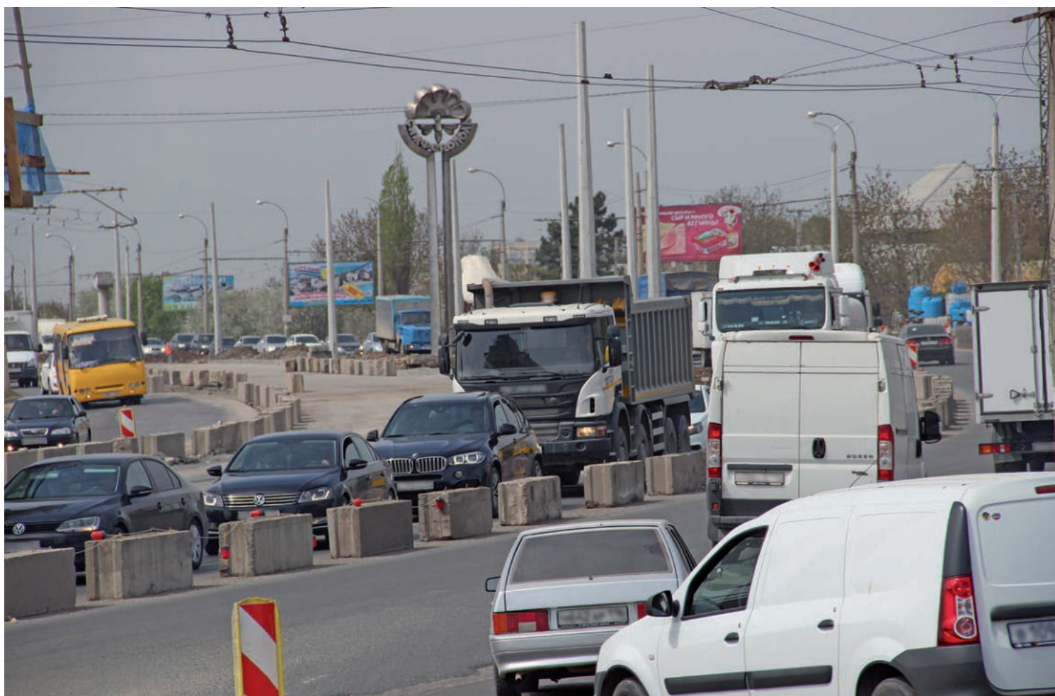
17 апреля. Симферополь. Подрядчик строительства развязки на Евпаторийской трассе признаёт небольшое отставание от графика. Фото: Михаил ГЛАДЧУК
