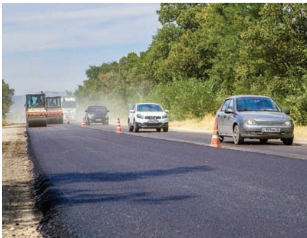
В прошлом году часть трассы Симферополь – Керчь в Белогорском районе была капитально отремонтирована. Фото: Лидия ВЕТХОВА
