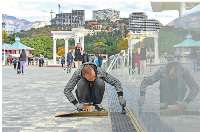
На набережной продолжаются ремонтные работы.
