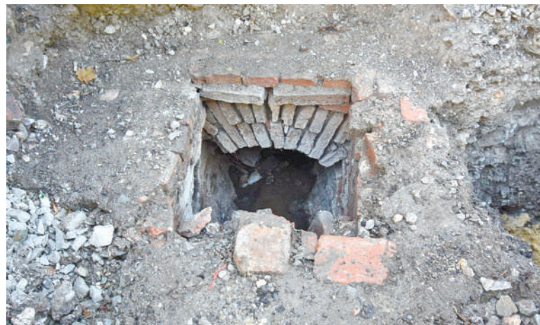
Старинные подземные сети преподнесли строителям много сюрпризов.
