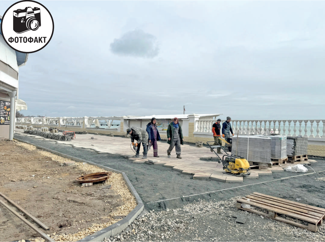
25 февраля, Евпатория. Работы по ремонту набережной им. Горького идут без выходных, когда это позволяют погодные условия. Фото: Александр Юрьев, «ВКонтакте».
