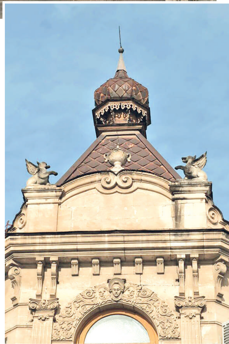
Необычные очертания постройке придаёт шатровая кровля над входом.
