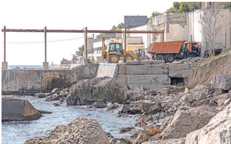
Набережная находится в состоянии ремонта.
