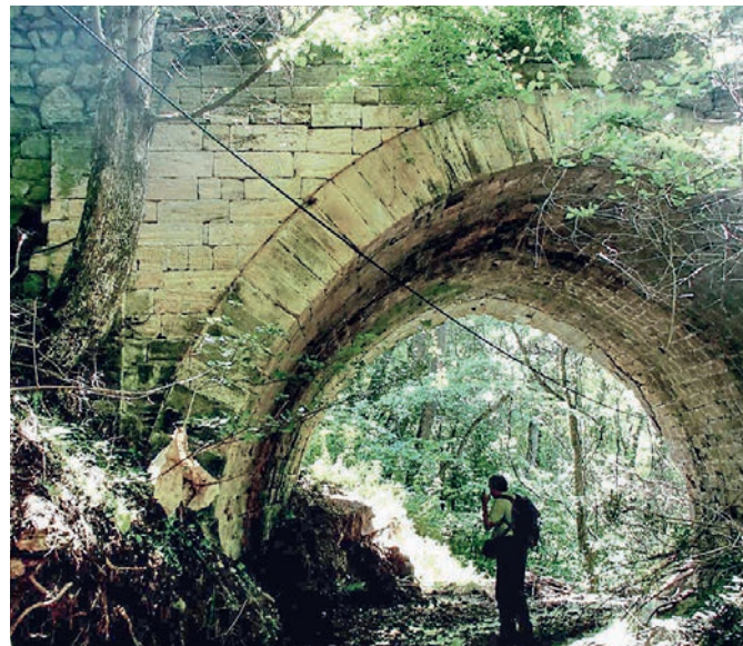
Жуковский высоко оценил качество шоссе, построенного по инициативе Михаила Воронцова. Каменный мостик стоит уже почти 200 лет.
