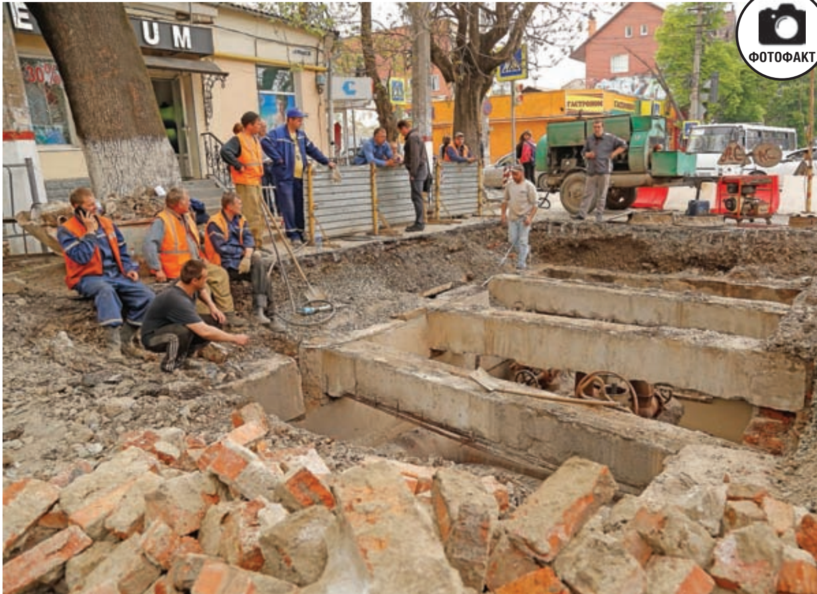
Симферополь. Ремонт на перекрёстке улиц К. Маркса и Толстого, похоже, волнует только автомобилистов. Фото: Лидия ВЕТХОВА
