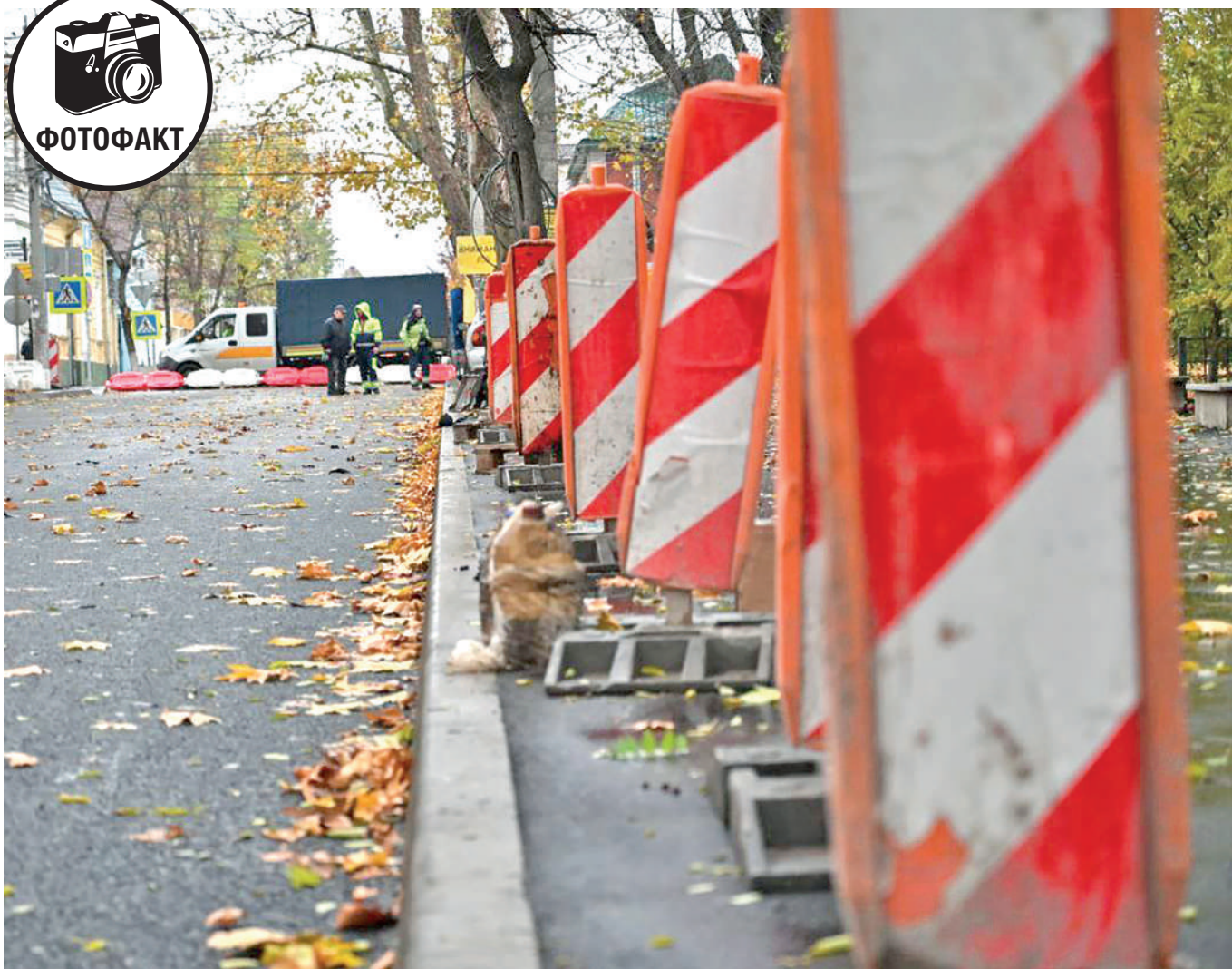
21 ноября, Симферополь. В крымской столице ремонтируют дорогу и тротуар на ул. Пушкина. Перекрыто движение для транспорта на участке от ул. Горького до ул. Гоголя. Для пешеходов проход открыт. Фото: Гала АМАРАНДО.
