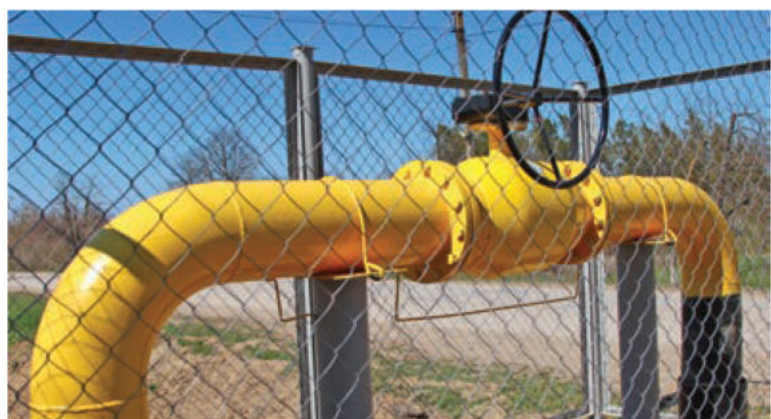
Газовые разводящие сети в Гришине построили, во втором полугодии начнут подключать абонентов.
