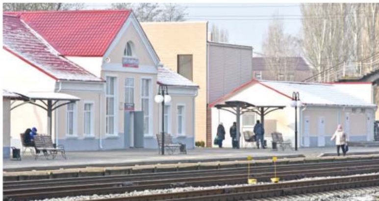
Отремонтирована ж/д станция «Краснофлотская».
