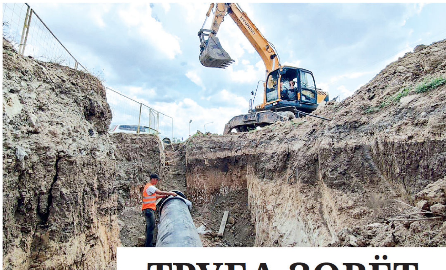
4 августа, Симферополь. На ул. Киевской идут работы на магистральном водоводе. Фото: Михаил ГЛАДЧУК
