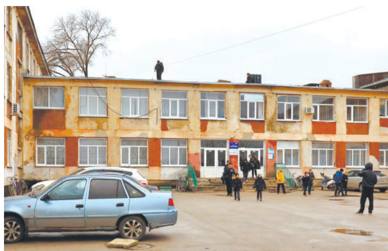
Рабочие восстанавливают крышу школы, повреждённую недавним ураганом.
