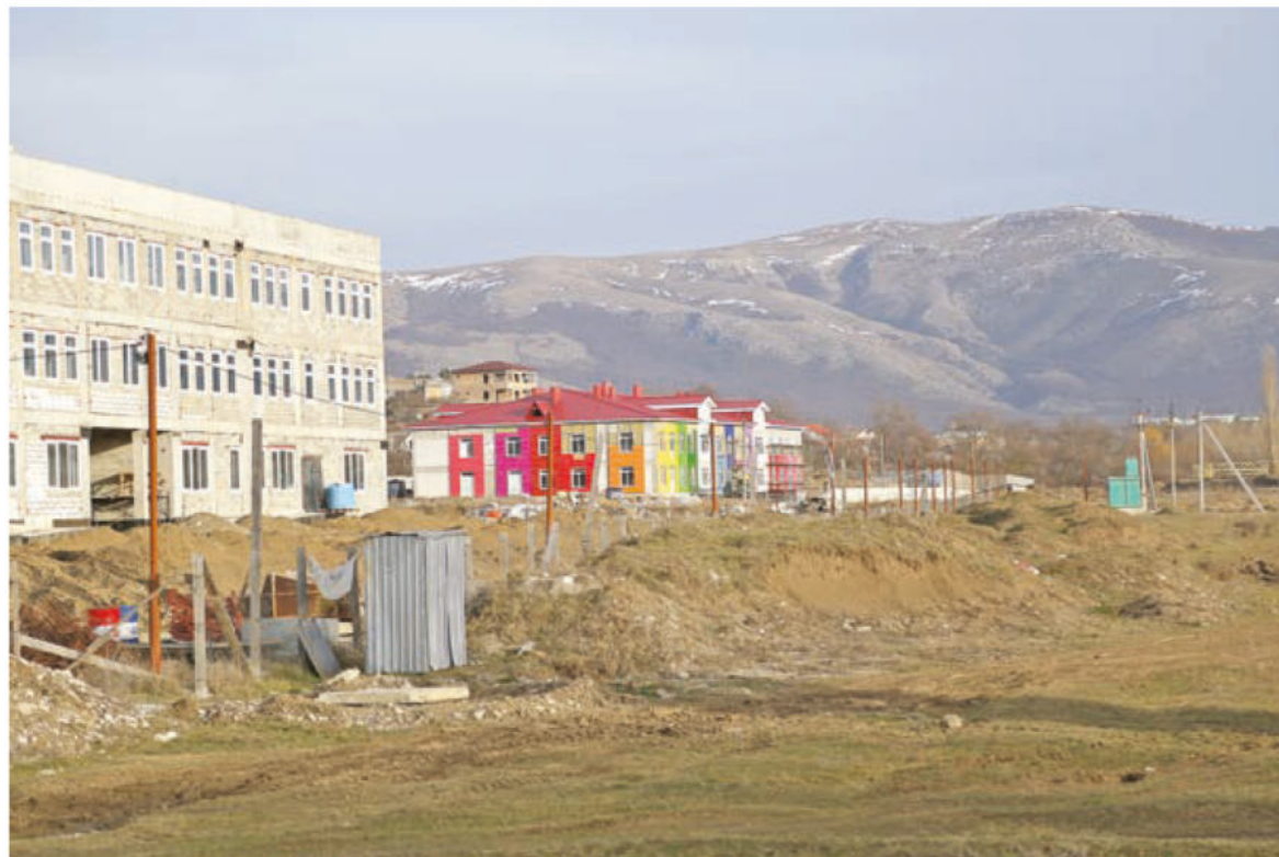
Строительство объектов ФЦП: модульного детского сада и школы.
