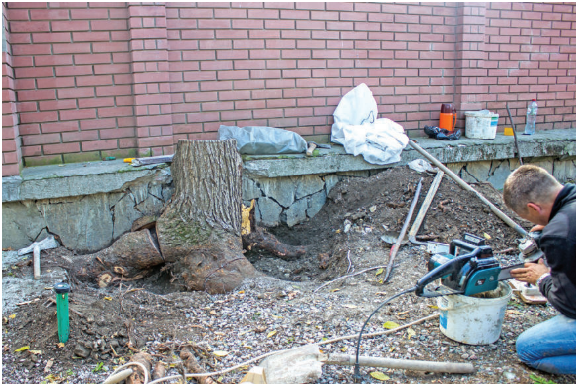
Спиленное дерево, как утверждают жильцы, мешало незаконно установленному забору.
