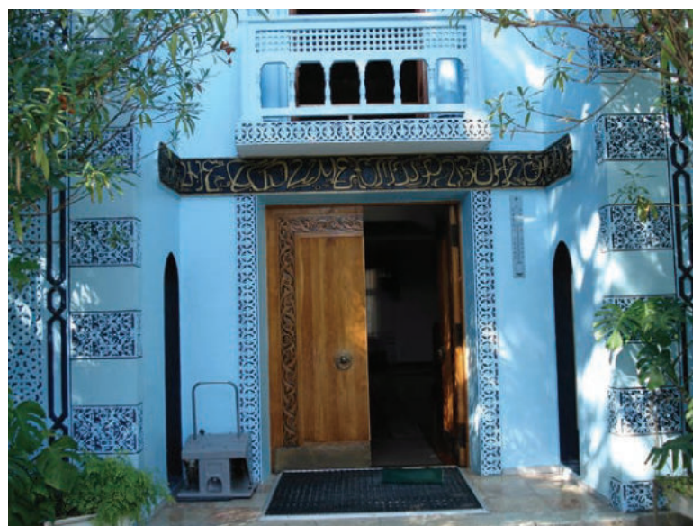
Второй спальный корпус санатория «Дюльбер» в Ялте. Над входом надпись из сталинской Конституции 1936 года: «Граждане СССР имеют право на отдых», стилизованная под арабскую вязь. Фото: yavpohode.ru
