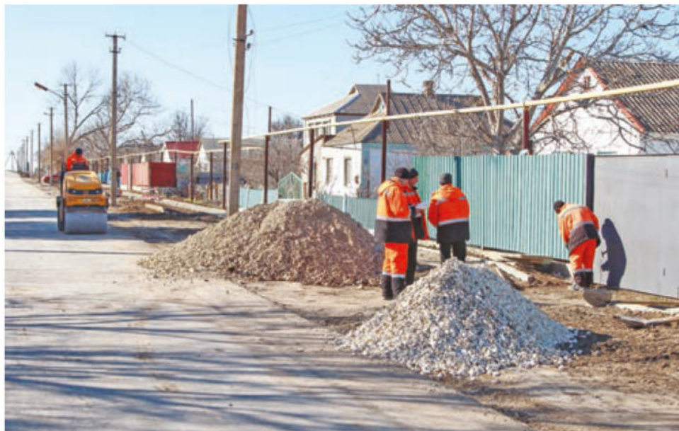
Заканчивается капитальный ремонт одной из главных улиц.
