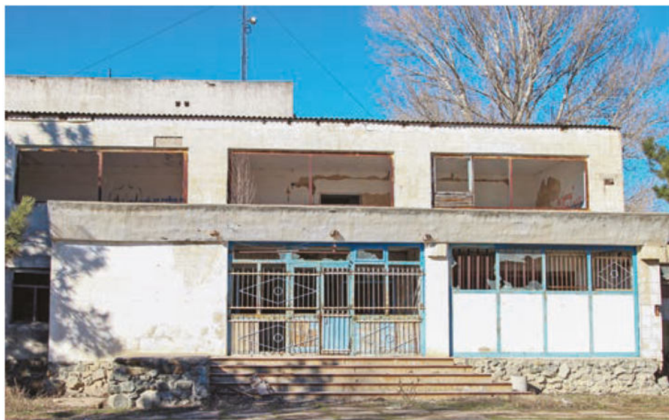
Здание заброшенного ДК потихоньку разбирают на стройматериалы.
