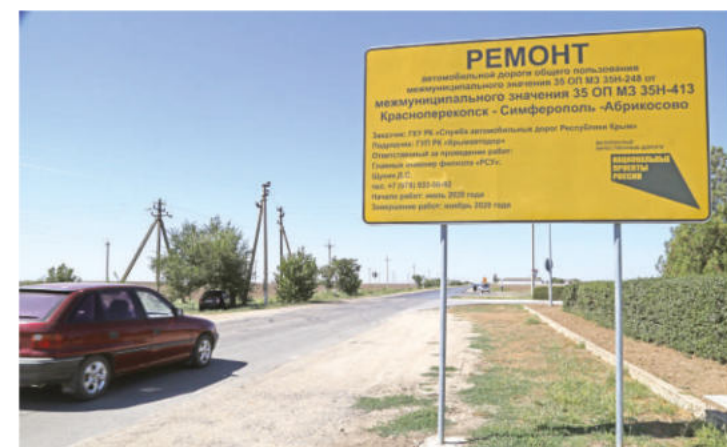
Дорога с новым асфальтом уже строится.
