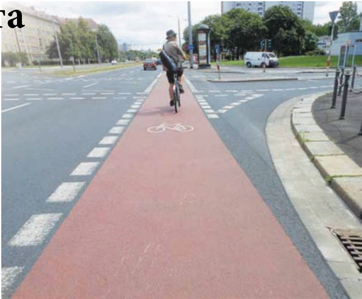
Теперь при проектировании дорог будут учитывать пешеходные и велосипедные дорожки.
