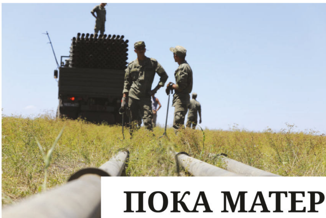
Подразделения материально-технического обеспечения Южного и Западного военных округов проложили более 50 километров трубопровода, который соединит Тайганское и Симферопольское водохранилища. Фото: Минобороны РФ
