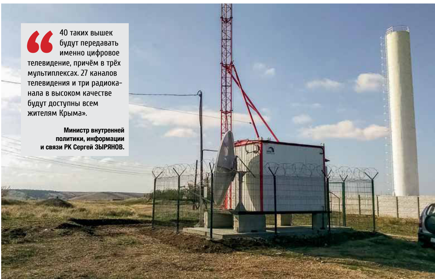
Новое антенно-мачтовое сооружение запустили в эксплуатацию в селе Пожарском Симферопольского района. Фото автора.
