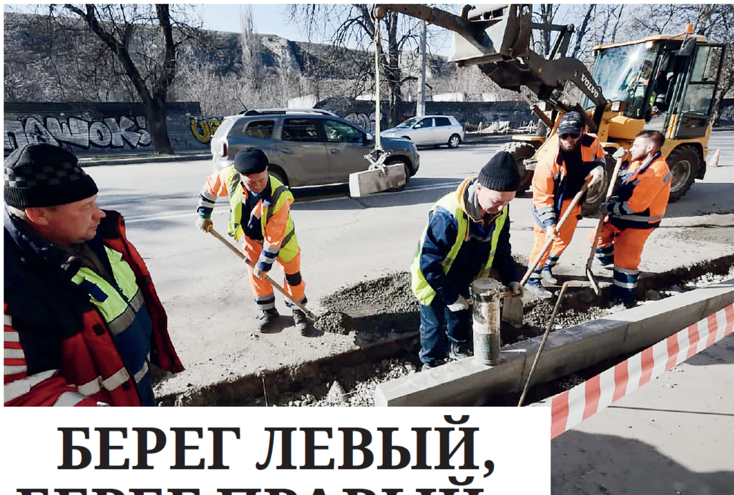
Дорожные рабочие приступили к ремонту улицы Воровского в Симферополе. Фото: Наталья СОМОВА
