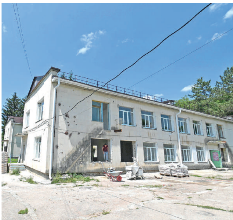
В январе начался капитальный ремонт детского сада.
