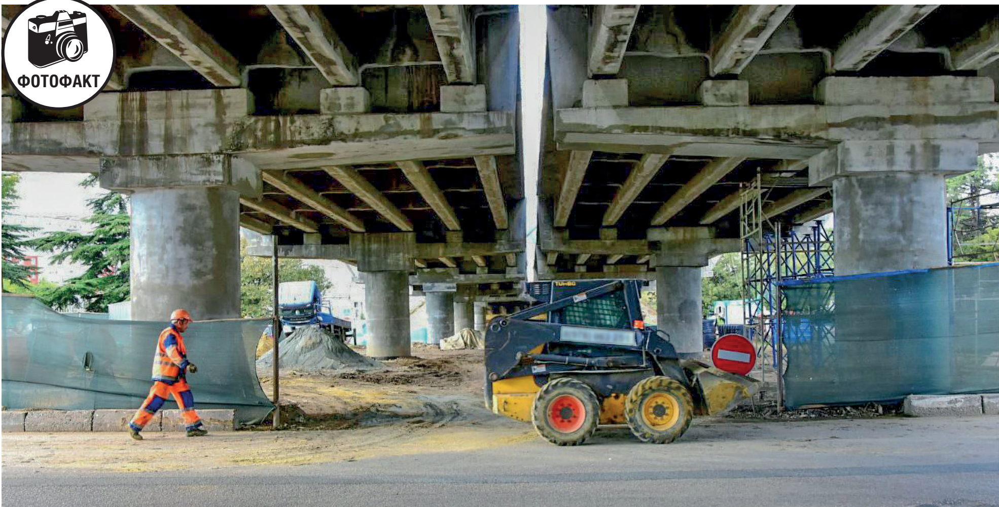
Ремонт искусственного дорожного сооружения (автомобильный мост на Бородинском кольце в Симферополе). Фото: Гала АМАРАНДО
