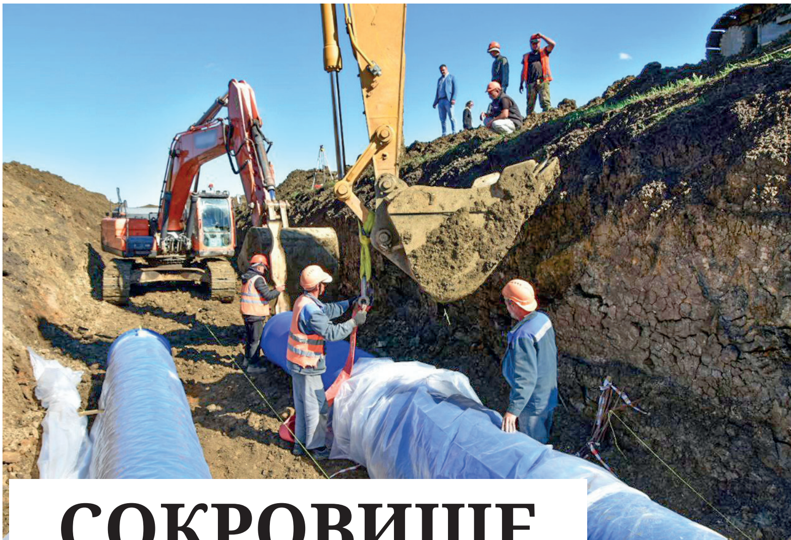
Прокладка труб тракта водоподачи. Локация – 2 км до Керчи.
