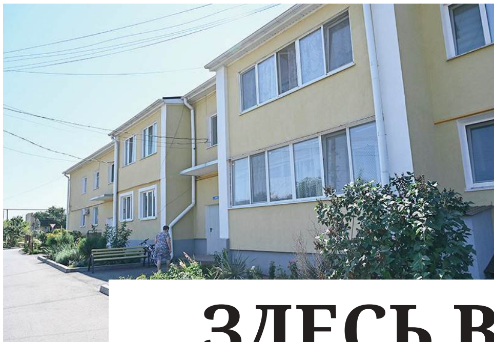
Многokвартирные дома капитально отремонтировали.
