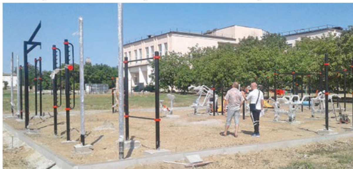
На площадке уже выполнили отсыпку и установили ряд тренажёров. Фото администрации Джанкойского района
