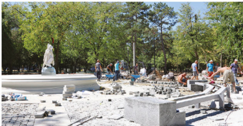
Подрядчик благоустройства Екатерининского сада обещает завершить работы вовремя. Фото: simadm.ru
