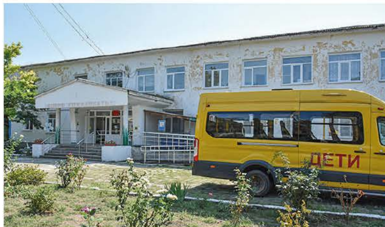
Капитальный ремонт школы не мешает учебному процессу.
