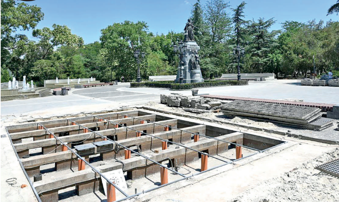
11 июля. Симферополь. В Екатерининском саду проводится ремонт и замена вышедших из строя элементов фонтана. Фото Галы АМАРАНДО.
