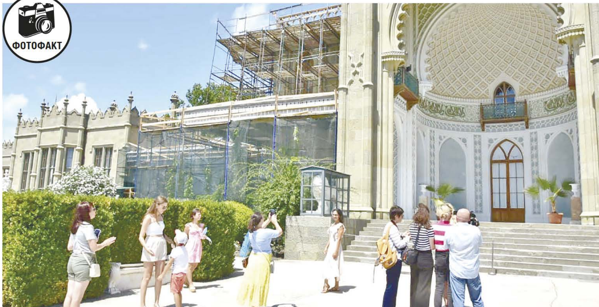
22 июля, Алушка. Продолжается реставрация Воронцовского дворца. Кровельные работы завершены на четверть. Фото Михаила ГЛАДЧУКА.
