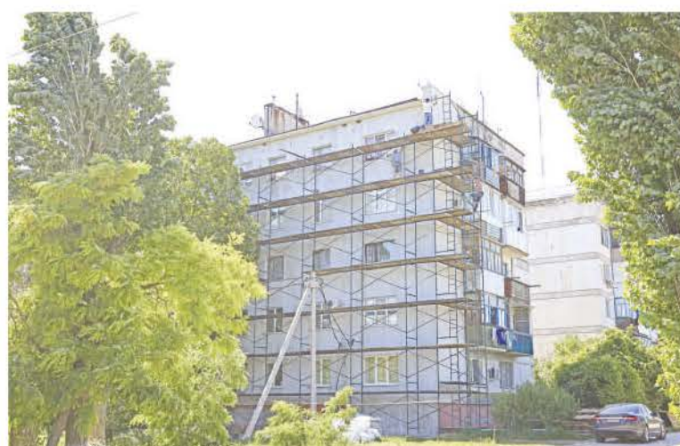
Капремонт пятиэтажек идёт ударными темпами.
