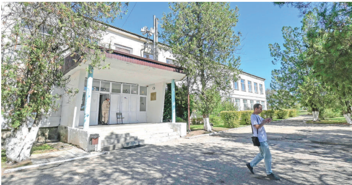
Школа. В прошлый наш визит она ещё была в состоянии ремонта.
