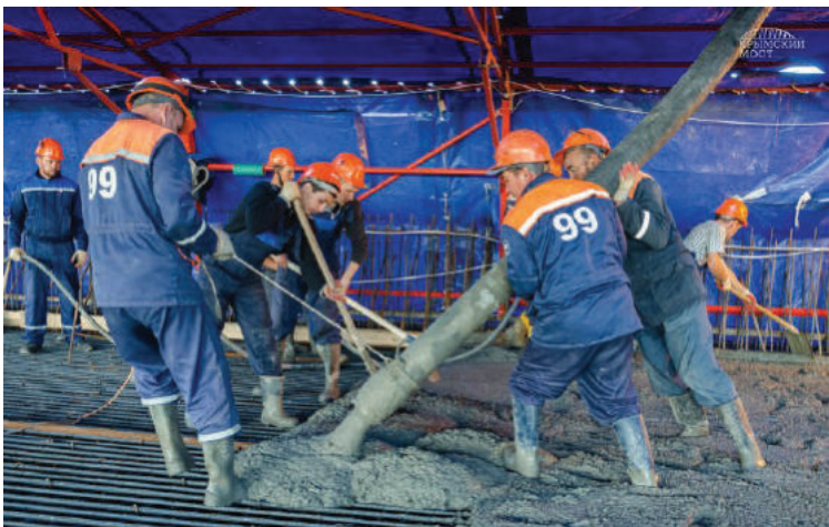
Так строители Крымского моста формировали плиту проезжей части.
