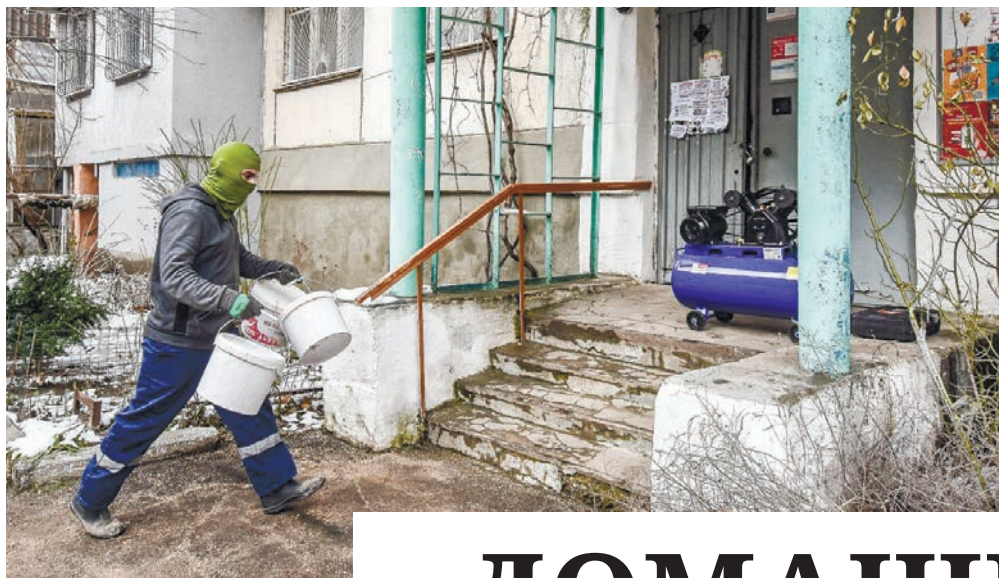
Ремонтные работы только начались.
