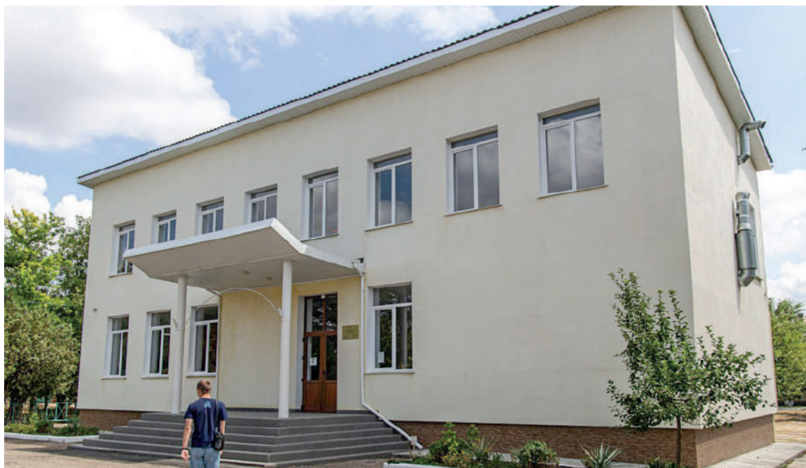
Дом культуры после капремонта.
