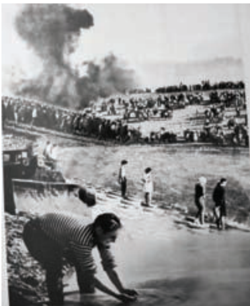
Знаменитый взрыв на Перекопском перешейке. 17 октября 1963 г. Фото из архива музея мелиорации Салгирского межрайонного управления водного хозяйства.
