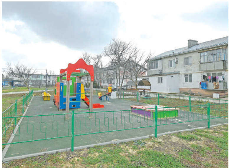
В четырёх МКД отремонтировали кровли, а во дворе установили детскую площадку.
