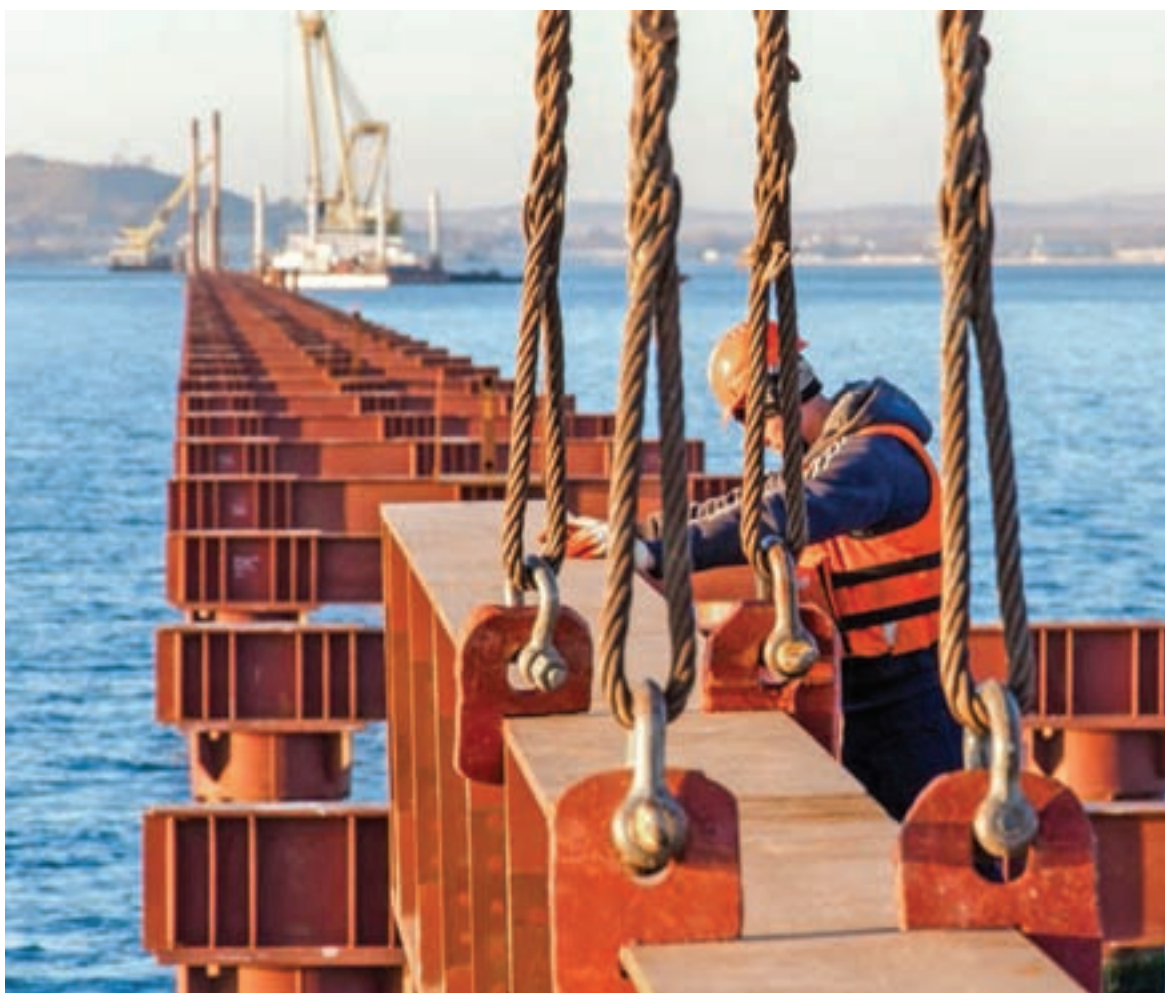
Мост продолжает строиться. Фото: «Крымский мост»
