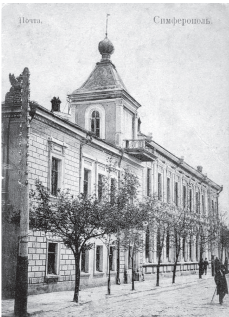
В 1860-х симферопольская почтово-телеграфная контора размещалась в двухэтажном здании в Почтовом переулке. Сейчас этого дома уже нет – он был разрушен при бомбежке в 1941-м, на его месте теперь сквер, разбитый в честь 200-летия Симферополя, а Почтовый переулок превратился в улицу Ушинского. ru.wikipedia.org
