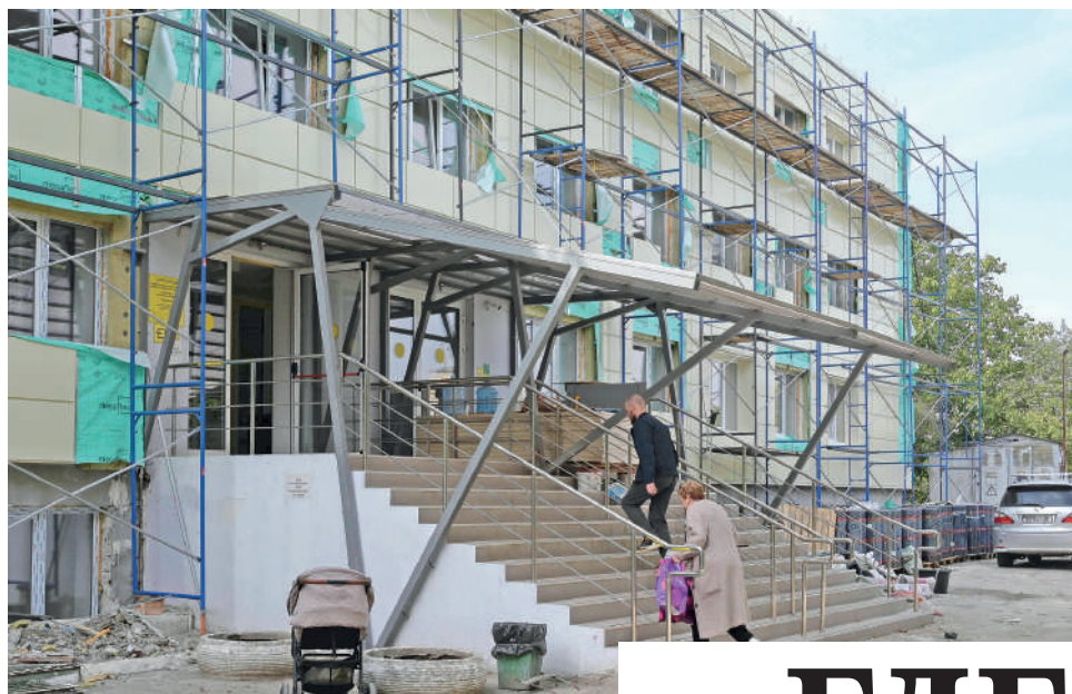
Идёт капитальный ремонт поликлиники.
