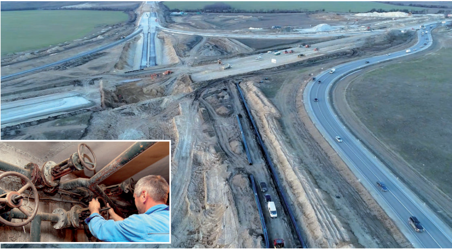
Отключение водоснабжения связывают в том числе и со строительством объездной Левадки – Дубки, так как здесь были проложены новые инженерные сети. Фото: ГК «Сибавтобан», otvprim.ru
