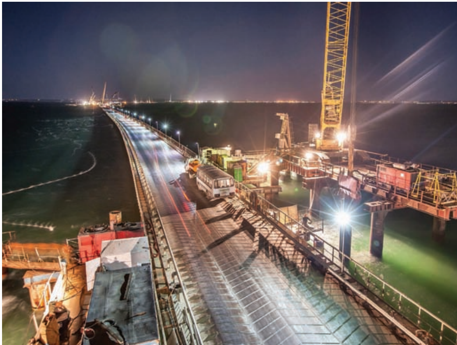
Работы по возведению моста ведутся круглосуточно. Фото: most.life
