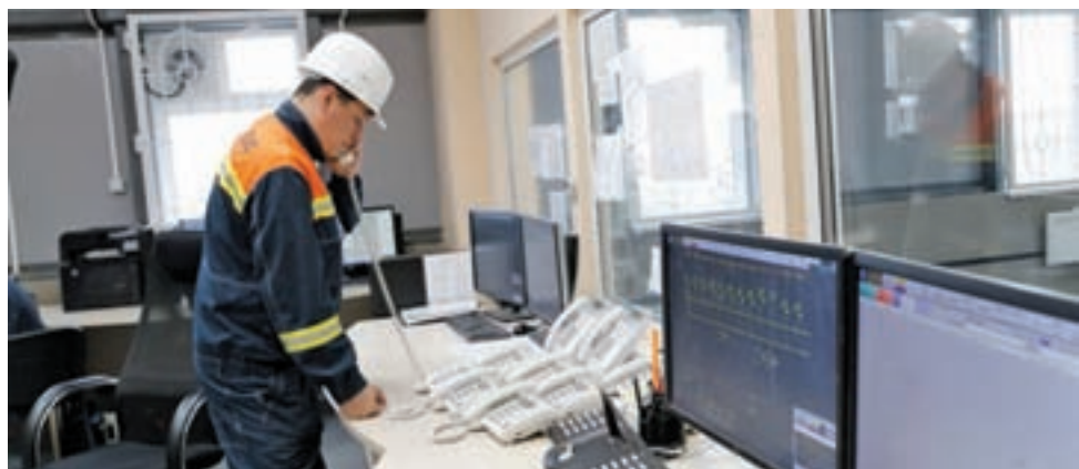
Подстанция Кафа – новая подстанция, построенная в Крыму для энергомоста. Фото: Лидия ВЕТХОВА
