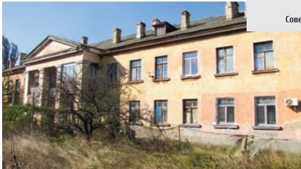
Дома в Цементной Слободке исчерпали свой ресурс, и в них просто опасно жить.
