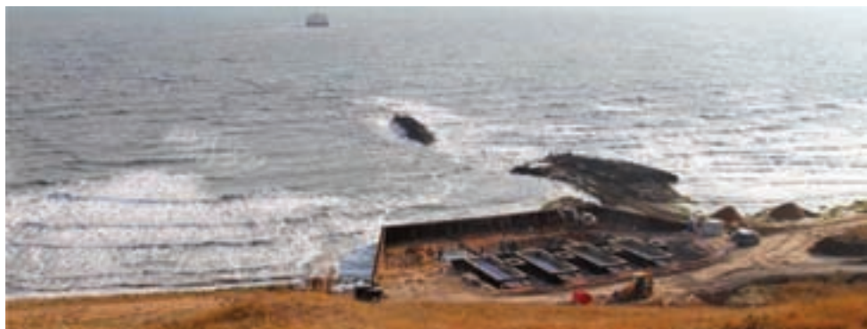
Начало строительства энергомоста. Фото: kerch.com.ru
