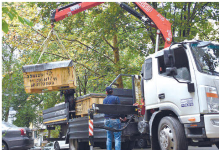
Уже скоро три сотни новых лифтов привезут к месту установки. Фото: Владимир ПРОШКИН
