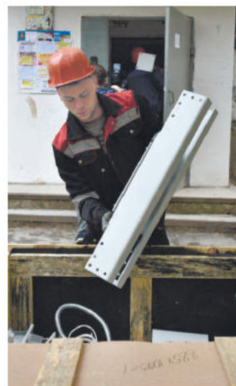
На демонтаж старого и установку нового лифта одной бригаде из трёх человек нужно порядка 45 дней. Фото: Владимир ПРОШКИН
