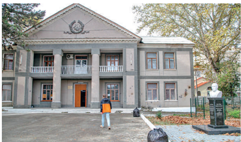
Снаружи здание сельского клуба сохранилось неплохо, а вот внутри требуется капремонт.
