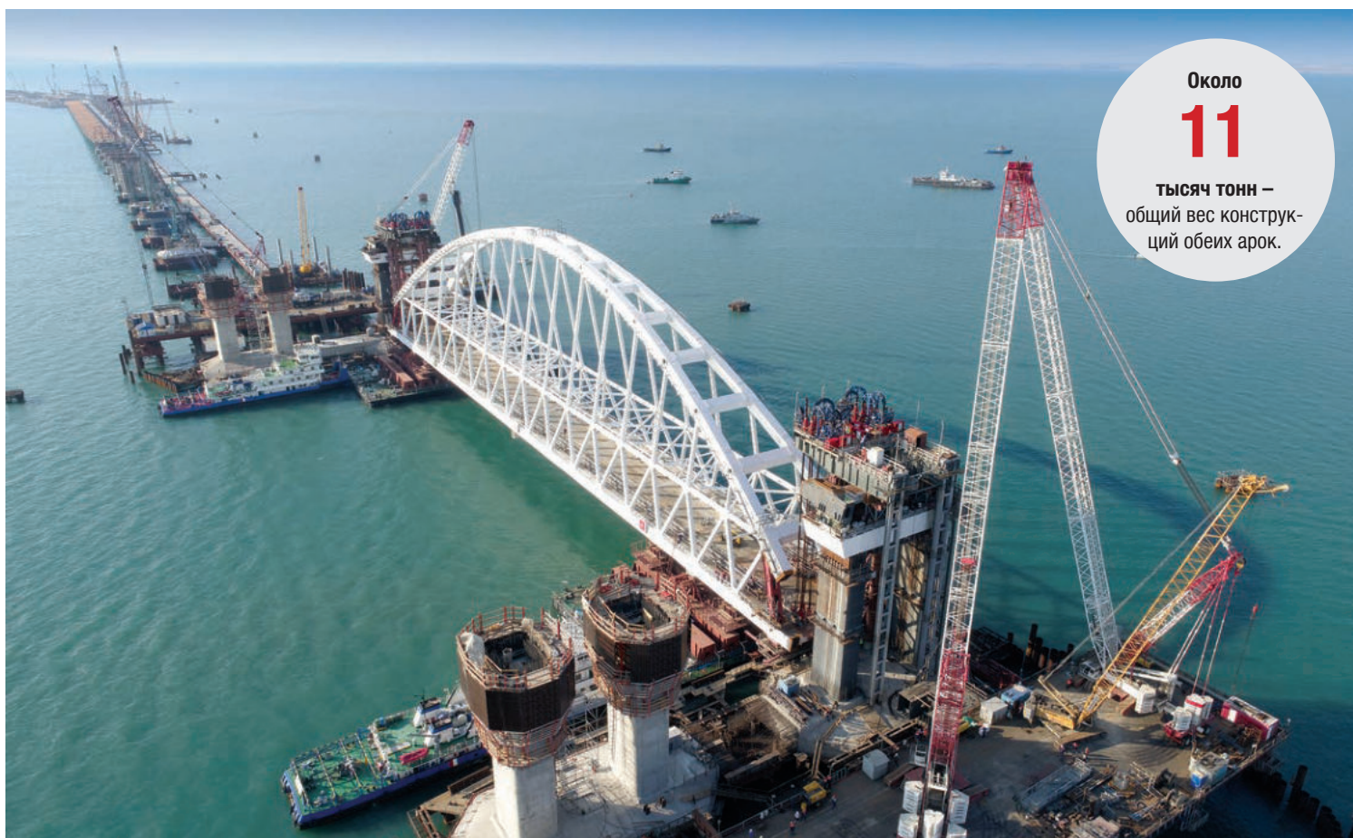
28 августа. В Керченском проливе идёт операция по установке железнодорожной арки Крымского моста. Фото: most.life
