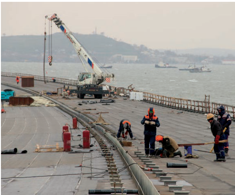
Рабочие делают барьерное ограждение. Фото: Михаил ГЛАДЧУК
