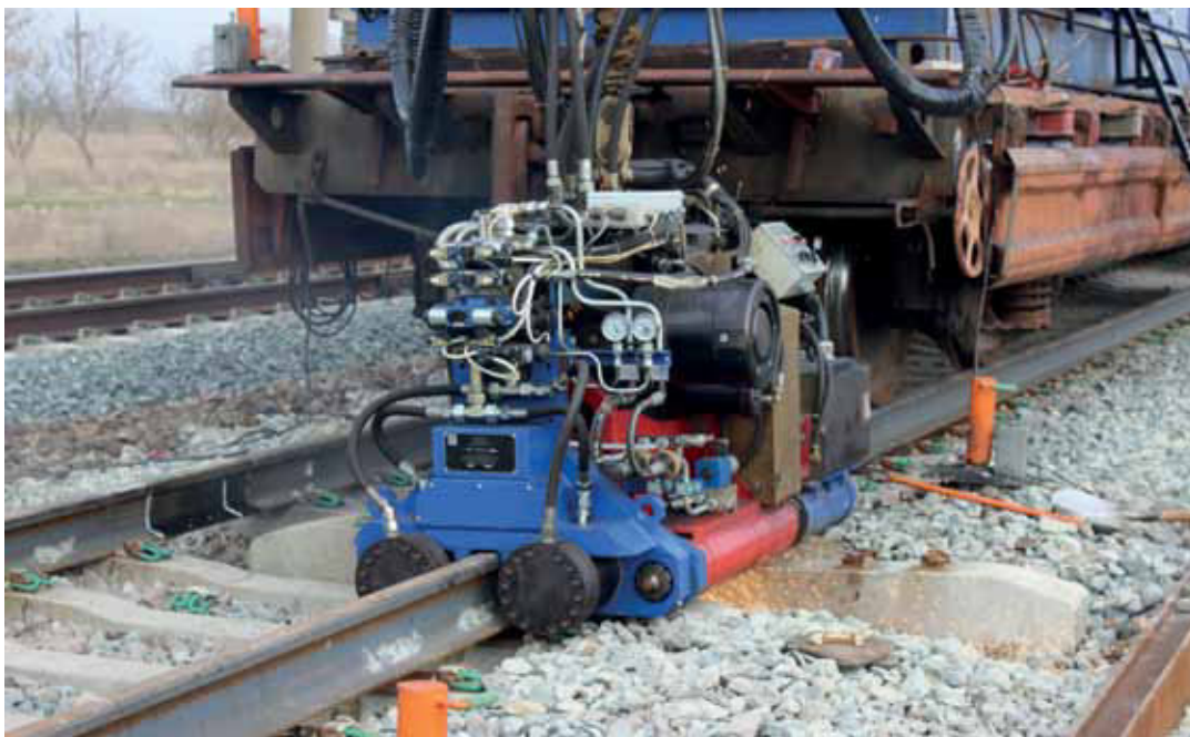
Специальный прибор для алюминотермитной сварки.
