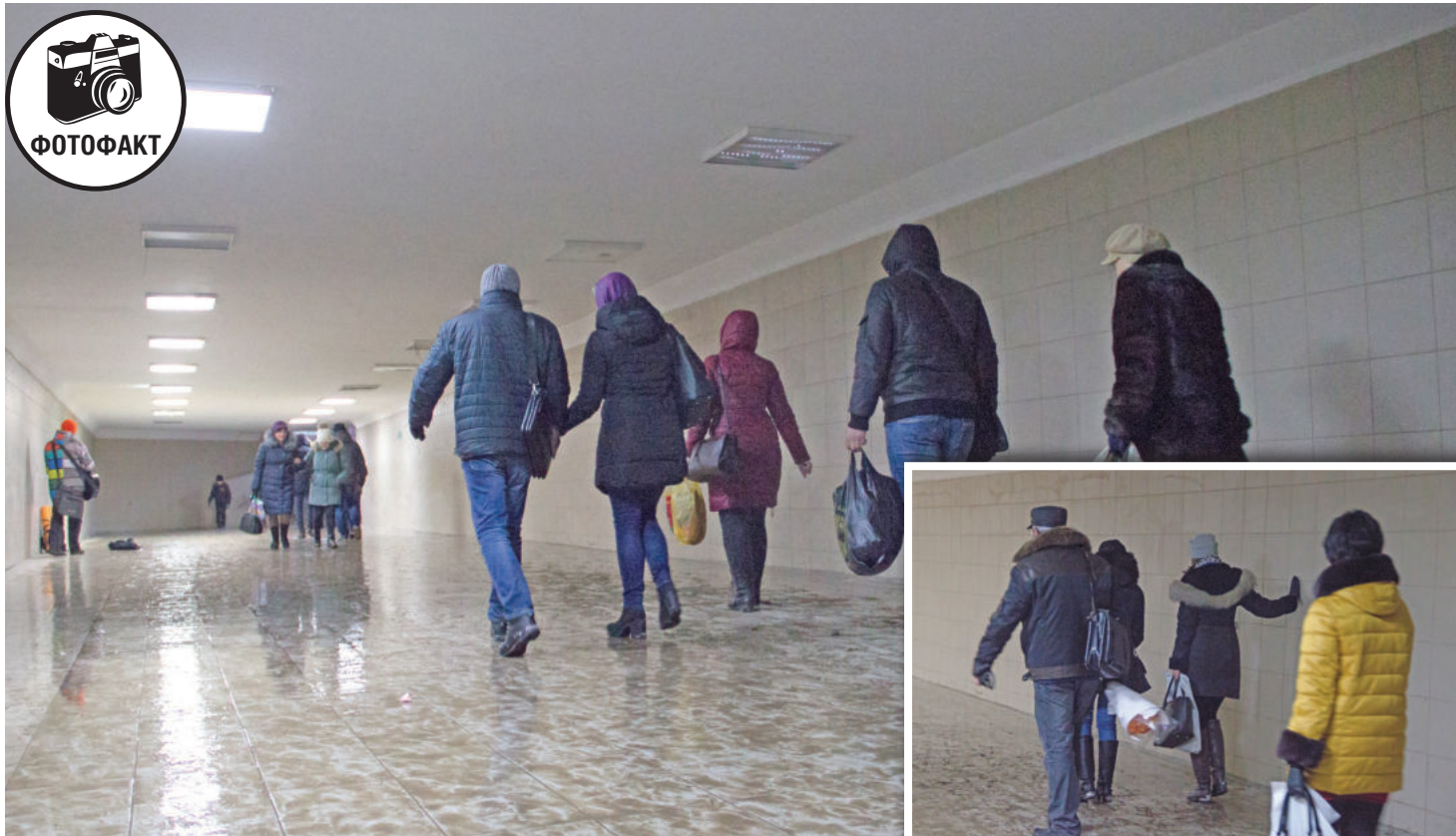
Симферополь. Подземный пешеходный переход на проспекте Победы, остановка ул. Бородина. Плитка здесь настолько скользкая, что при гололёде пешеходы рискуют упасть. Фото: Михаил ГЛАДЧУК.
